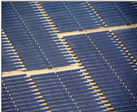
Nellis AFB, USA 5/ 14 MW
